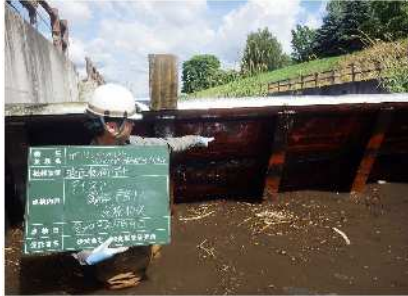
堰の年点検状況
