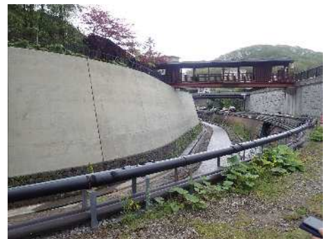
工事後の状況
