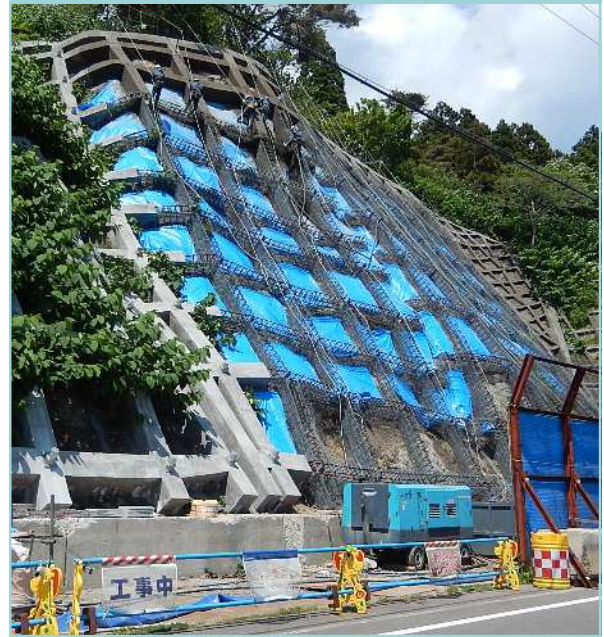
施工中 [アンカー付きのり枠]
