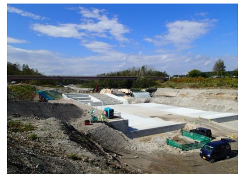
工事中の床止工
