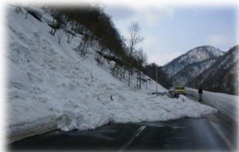
雪崩による道路寸断
