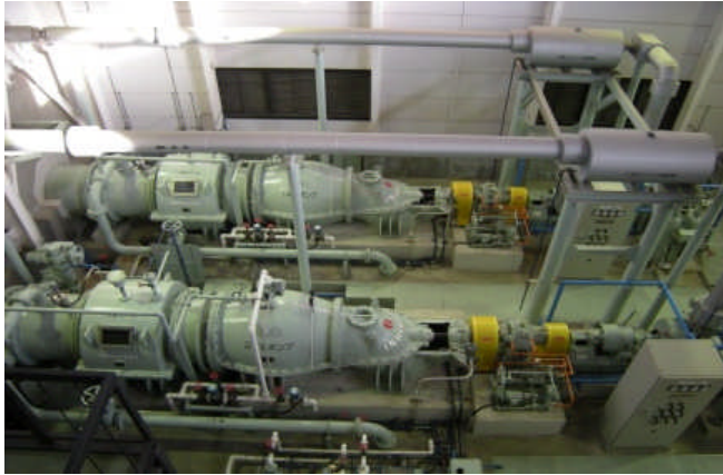
設置後 14 年を経過した排水機場
