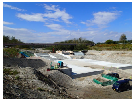
工事中の床止工
